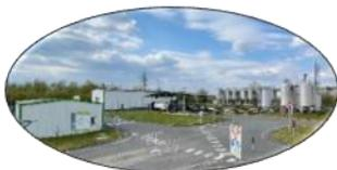
AUREA a acquis en février 2021 une usine de régénération de solvants par distillation sise à Beator dans l'Aisne, exploitée par la filiale SARGON. Cette usine, créée en 1999 par le Groupe SUEZ, a une capacité de traitement de 12 000 tonnes par an, et dispose d'une capacité de stockage de 1 000 m<sup>3</sup> en vrac et de 480 tonnes en conditionné.
